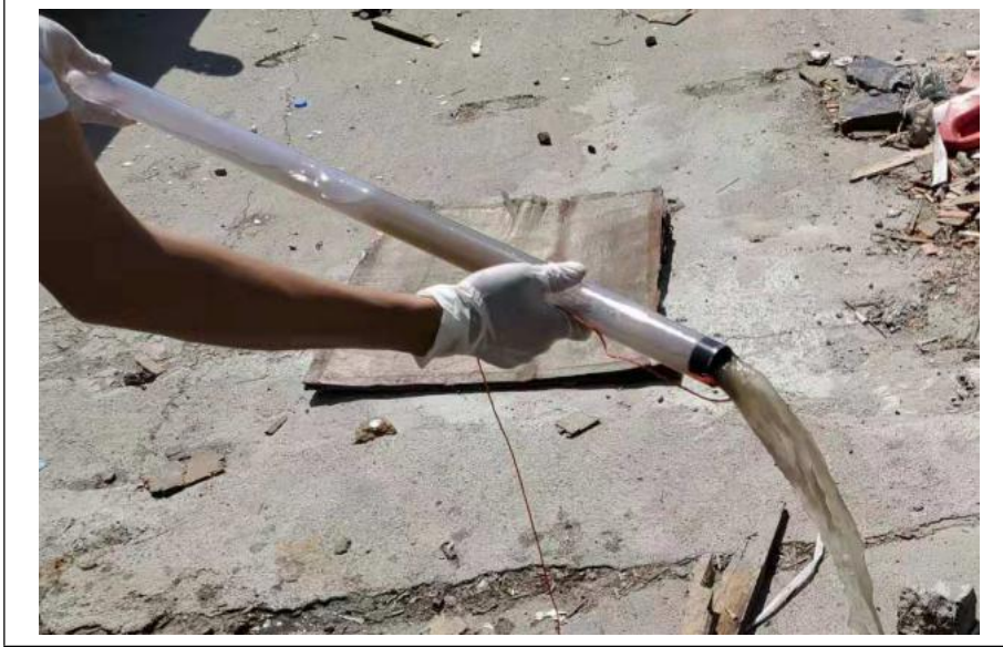
图 6-6 洗井现场工作照片
