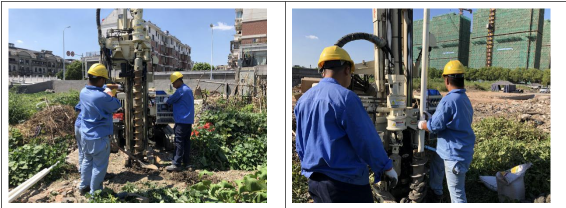
图 6-5 建井现场工作照片
