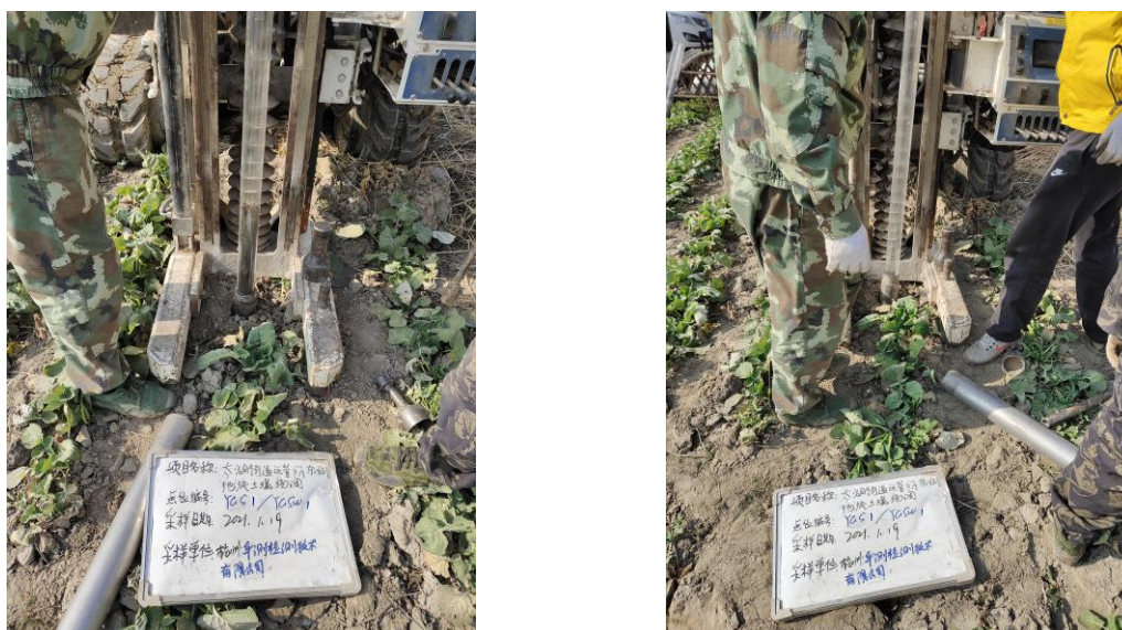
图 5-1 土孔钻探现场照片
