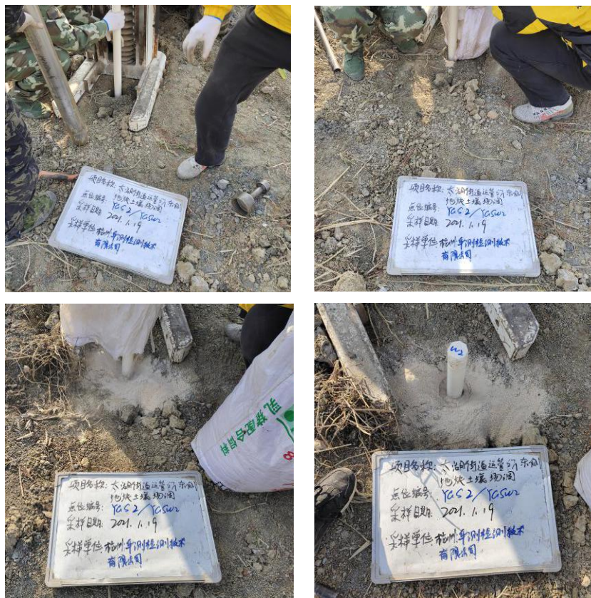
图 5-5 建井现场工作照片
