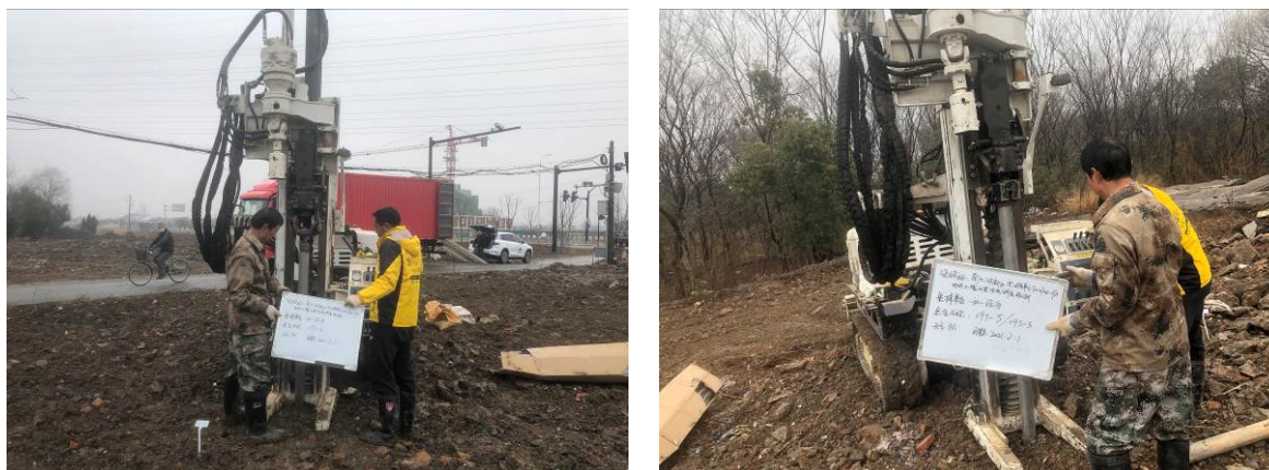
图 5-1 土孔钻探现场照片
