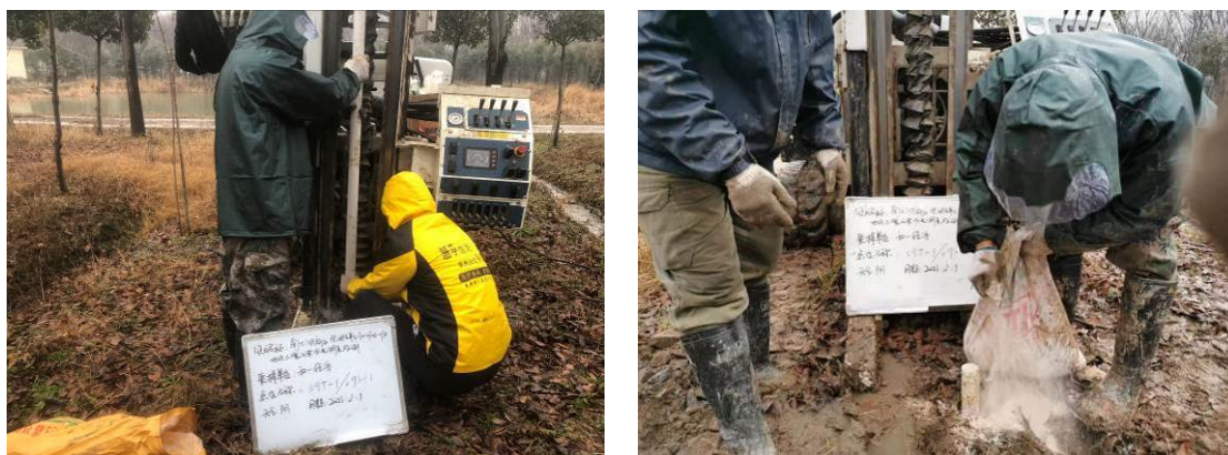
图 5-6 建井现场工作照片
